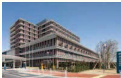
震度7の揺れを震度4程度に軽減できる免震装置の他、地下水利用システムにより、自前で水の確保ができます。
